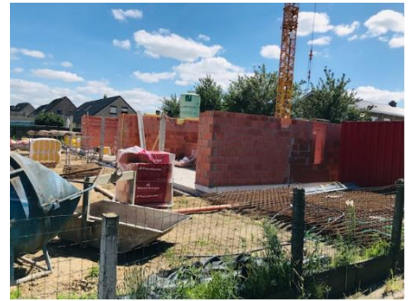
Datum : 03/07/2020 : de eerste bouwstenen van het gelijkvloers
